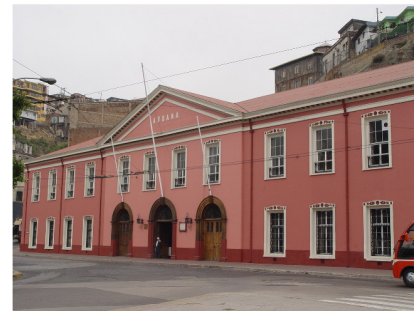
Edificio de la Dirección Regional Aduana de Valparaíso
